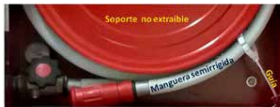
Soporte o carrete no extraíble. La manguera se desenrolla ayudada por un dispositivo orientador o "guía"
