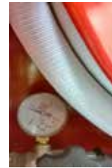
Detalle de BIE de manguera SEMIRRÍGIDA: puede utilizarse sin desenrollarla por completo
