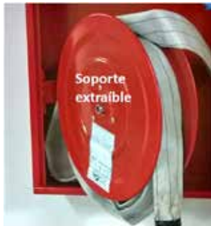
Soporte o carrete extraíble que pivota sobre un eje, quedando perpendicular al armario
